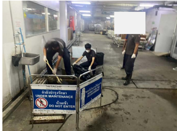
รูปที่ 2.2-29 ขุดลอกท่อระบายน้ำ
